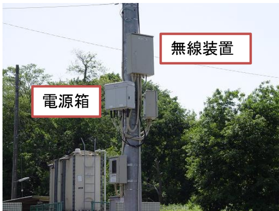
基地局での装置設置例（従来）
